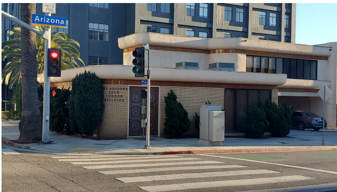
Vistas de edificio des de afuera.
